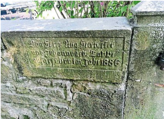
Die Tafel von 1886 an der Hofmauer erinnert an August Heermeier und Johanne geb. Tappe, die weitere Modernisierungen am Hof vornahmen.
